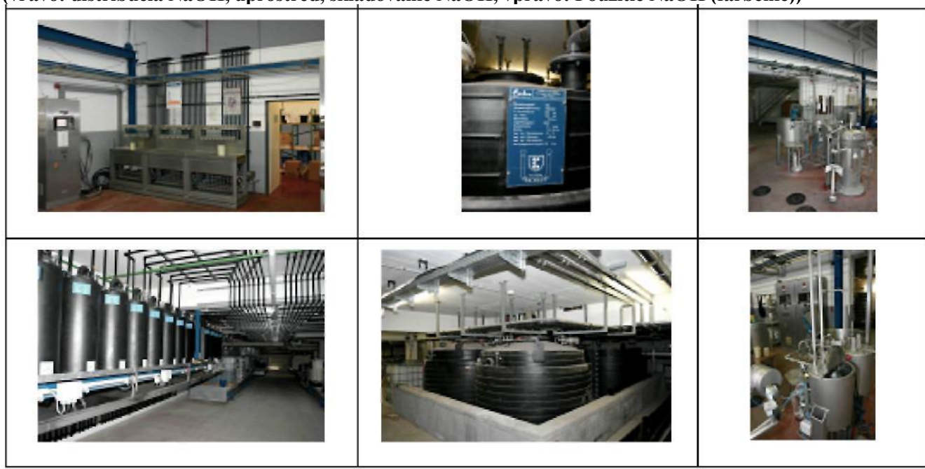
Obr. 1: Dnes sa v textilnom priemysle NaOH používa v uzavretých systémoch, bez expozície pracovníkov (vľavo: distribúcia NaOH, uprostred, skladovanie NaOH, vpravo: Použitie NaOH (farbenie))
